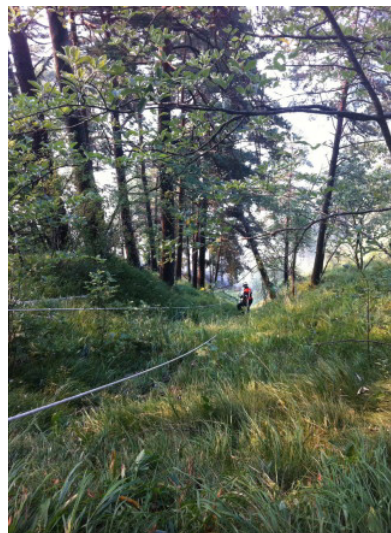
4. Nur gesichert war ein Arbeiten am steilen Hang möglich. Hier steigt Christian Burr mit dem ersten C-Rohr 70m tief in den Hang ein.
